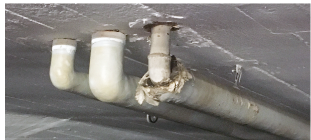
Defekte Wärmedämmungen reparieren.
